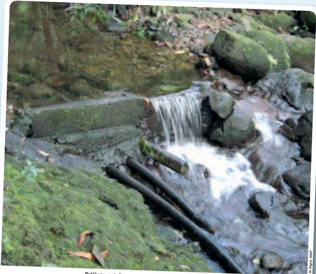
*Prélèvement d'eau en ravine à l'aide d'une petite retenue*
