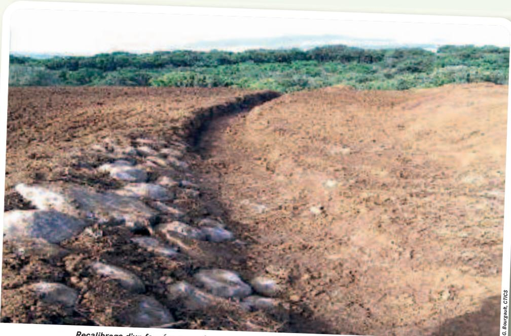
*Recalibrage d'un fossé avec renforcement des berges dans les zones les plus exposées*
